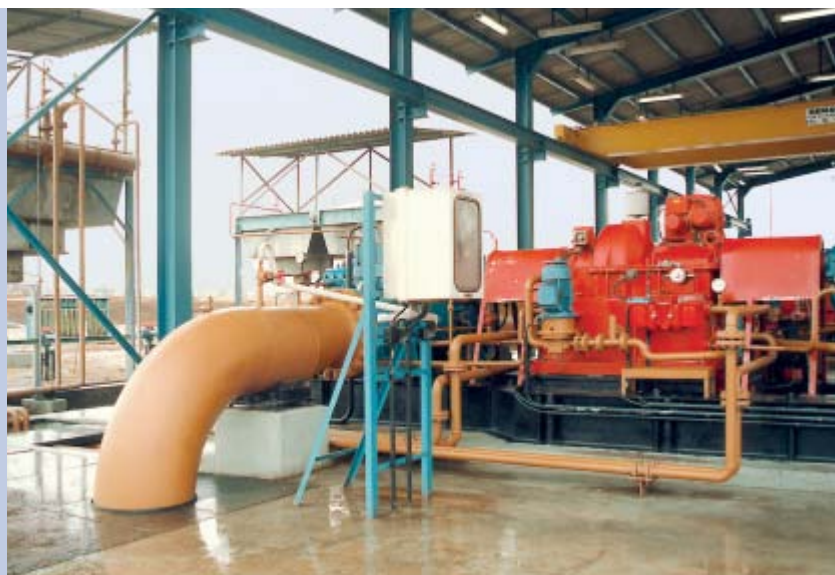
Регулируемая турбомуфта типа SVL в приводе насоса для магистрального трубопровода.
