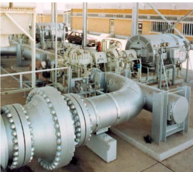
Регулируемая турбомуфта типа 562 SVL в приводе для насоса сырой нефти/морской промысел.
